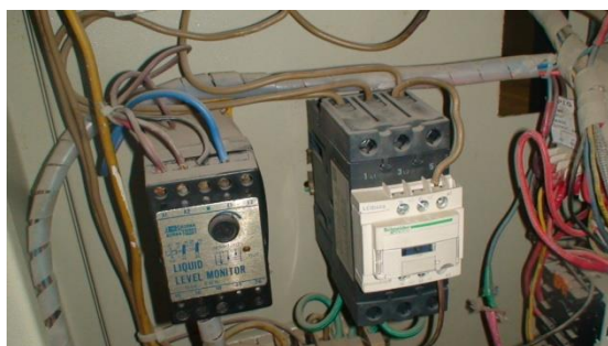
شکل ۱۰۸- کنتاکتور در اتوکلاو
